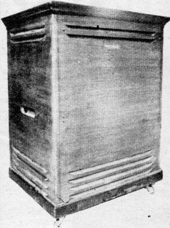
• **KING MASTER:** Amplificador para órgano de 90 Watts de potencia R.M.S., totalmente transistorizado, construido en madera multilaminada de 20 m.m.
